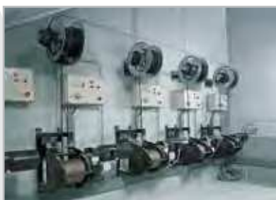
Treuil électrique pour les scènes et studios avec enrouleur de câble
